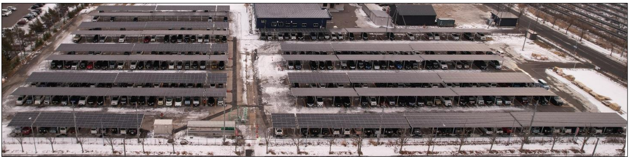
ソーラーカーポート (AC100V、出力2, 400Wの自立運転可能)
