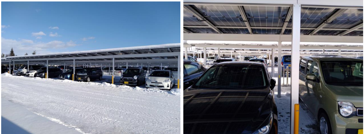
カーポート型太陽光発電設備 外観 (両面受光パネル採用)
