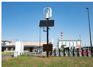
Windbetriebener elektrischer Generator
